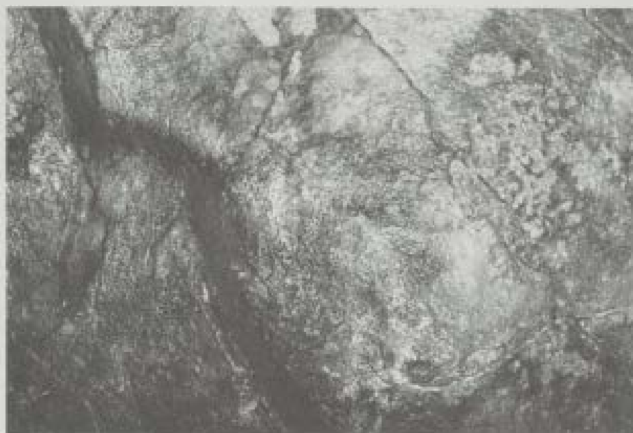
75 — Detalle de la figura rellenada con cemento hidráulico.
