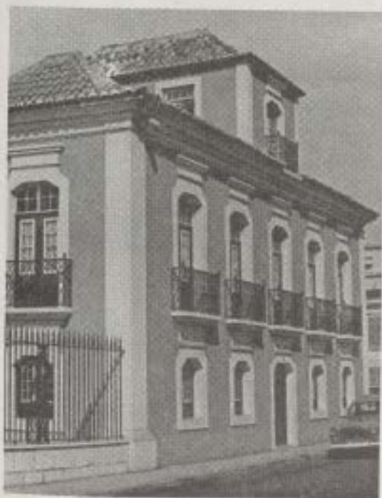
Palacete setecentista de Luanda, que a Companhia de Diamantes de Angola adquiriu para instalar um Museu de Arte Africana, designado "CASA-MUSEU ERNESTO DE VILHENA"; Está ali instalado desde 1975 o MUSEU NACIONAL DE ANTROPOLOGIA.
