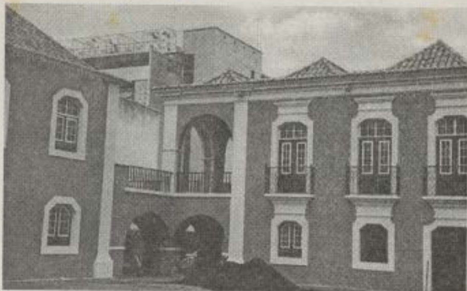
MUSEU NACIONAL DE ANTROPOLOGIA Aspecto parcial das fachadas do pátio interior de acesso.
